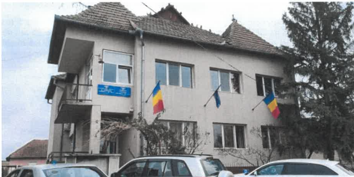
Fig. 2. C1 – Clădire administrativă – Primaria Hidișelu de Sus – clădire independentă
