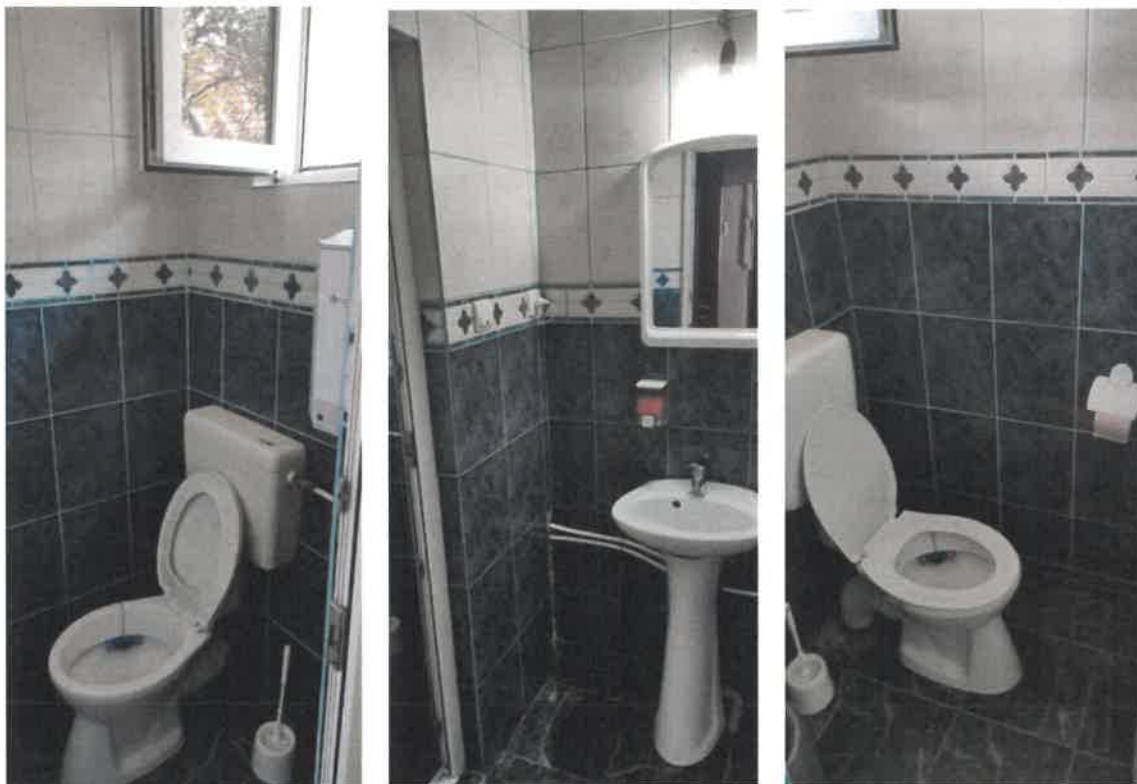
Fig. 6. Clădirea administrativă – Primaria Hidișelu de Sus Grupuri sanitare – pardoseală gresie
