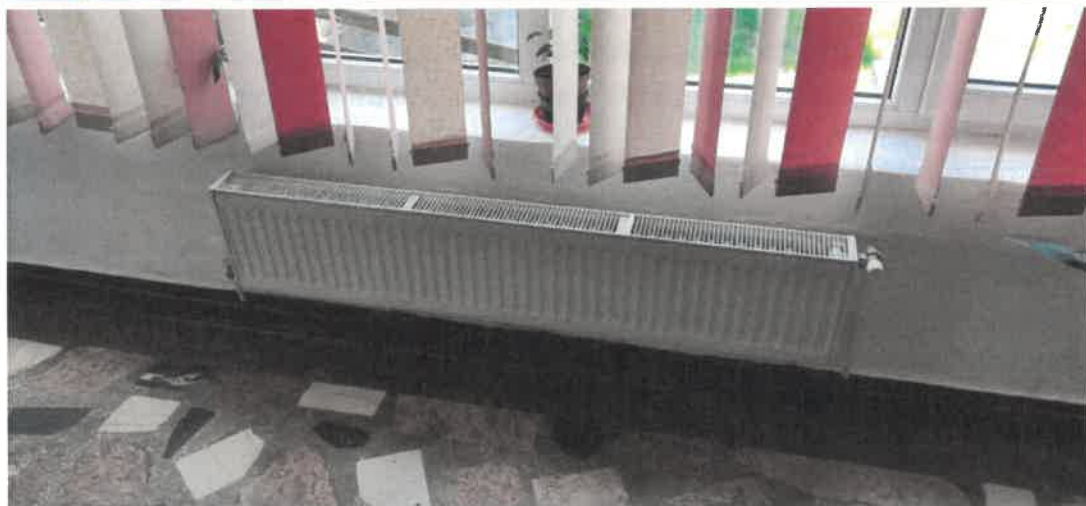
Fig. 7. Imagini corpuri statice / calorifere din tablă. Tâmpărie PVC
