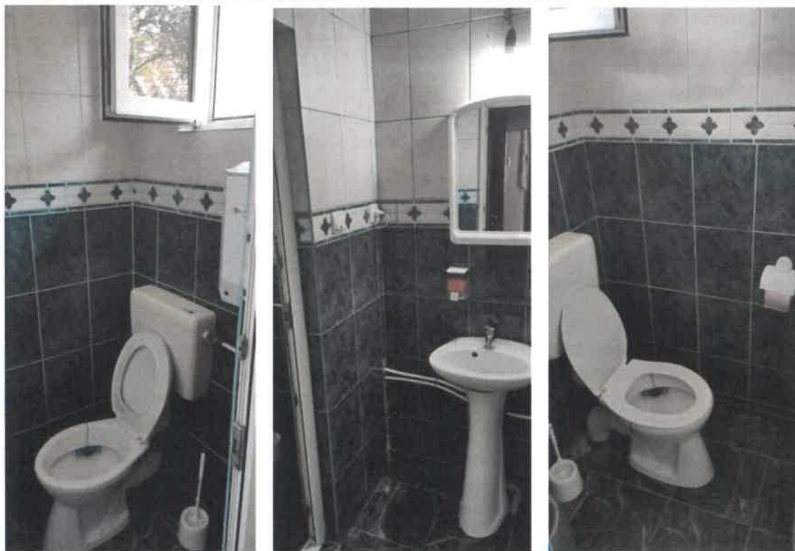
Fig. 6. Clădirea administrativă – Primaria Hidiselu de Sus Grupuri sanitare – pardoseală gresie
