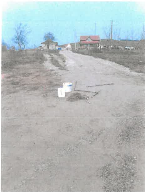
S1 – sondaj geotehnic
