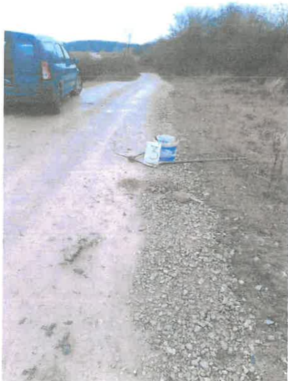
S3 – sondaj geotehnic
