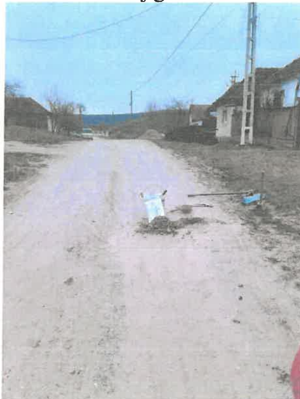
S4 – sondaj geotehnic
