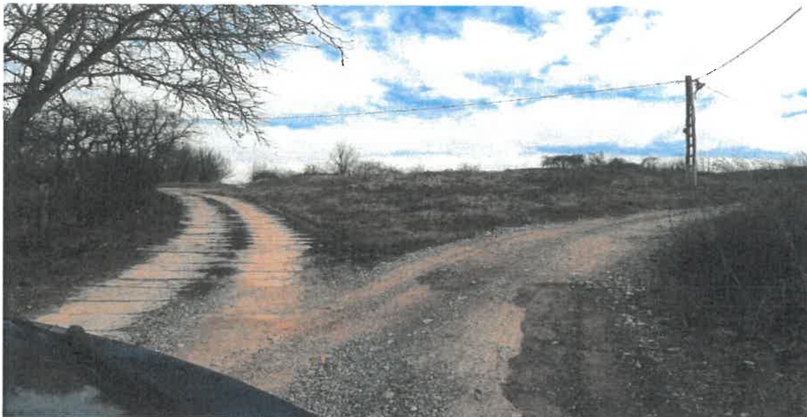
Poza 7 - vedere strada Spre Statia de pompare din intersectie cu drum lateral
