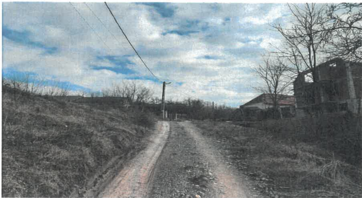
Poza 8 - vedere strada Spre Statia de pompare
